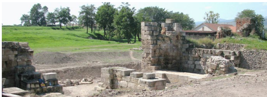
Ruinele castrului roman de la Apulum înainte de restaurare
