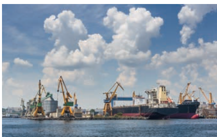
3. Șantier naval – Constanța
