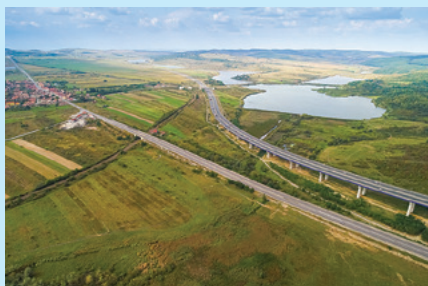
Viaductul Aciliu (autostrada A1)
