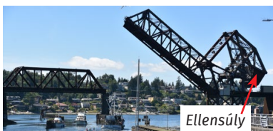
1. ábra – A híd emelkedése közben az ellensúly süllyed, és munkát végez.
