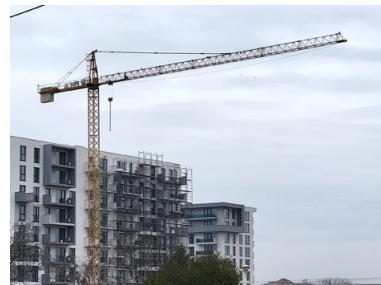
1. ábra – Kiegyensúlyozott toronydaru
