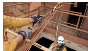
3. ábra – Emelés csigarendszerrel
